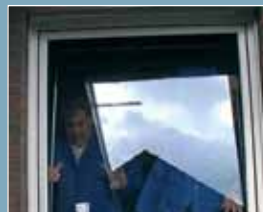
Bild 3: Die neue Scheibe wird eingesetzt.
