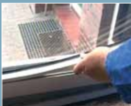
Bild 1: Die alte Scheibe wird entfernt. Der Rahmen wird sorgfältig gesäubert und vorbereitet.
