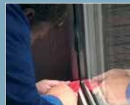
Bild 4: Die neue WS-Scheibe wird im modifizierten Fensterflügel abgedichtet.
